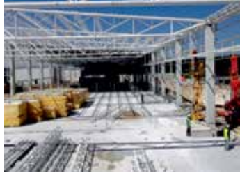
Çelik Konstrüksiyon Steel Construction
